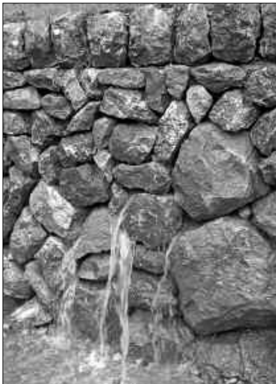
Fotografia 1. El marge de pedra en sec facilita el drenatge de l'aigua acumulada a la marjada.
