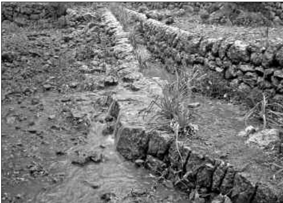
Fotografies 6 Desbordament d'una ratlla de drenatge per rebliment.
