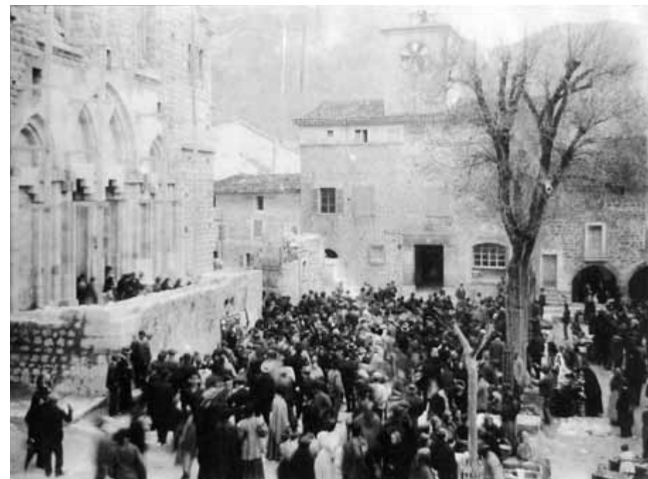
Sortida de missa major i mercat a la plaça de la Constitució, la dècada del 1910. La façana està en obres i la muralla a mig enderrocar (Foto arxiu P. Pérez).
