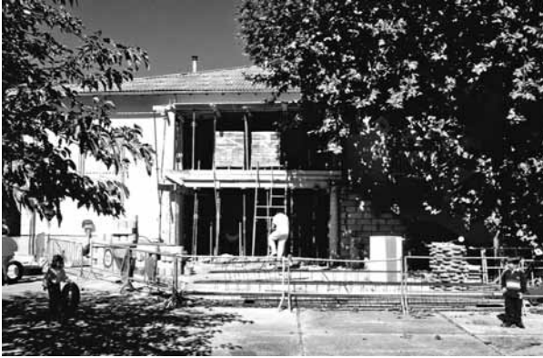
Construcció d'una nova aula i gimnàs (posterior menjador) el 1995 (Arxiu Fossaret)
