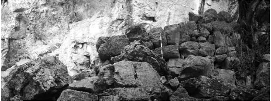
Mur extern del coval d'en Toni de Cúber.
