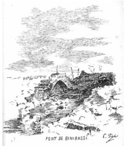
Pont de Binibassí després de les inundacions del 1885. Dibuix de Cristòfol Piza
